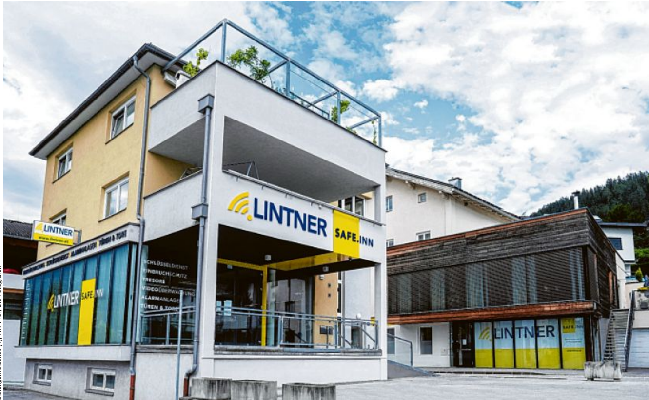
Das Betriebsgebäude von Lintner Sicherheitstechnik und der Sicherheitsshop SAFEINN liegen direkt gegenüber an der Tiroler Straße in Schwaz.
